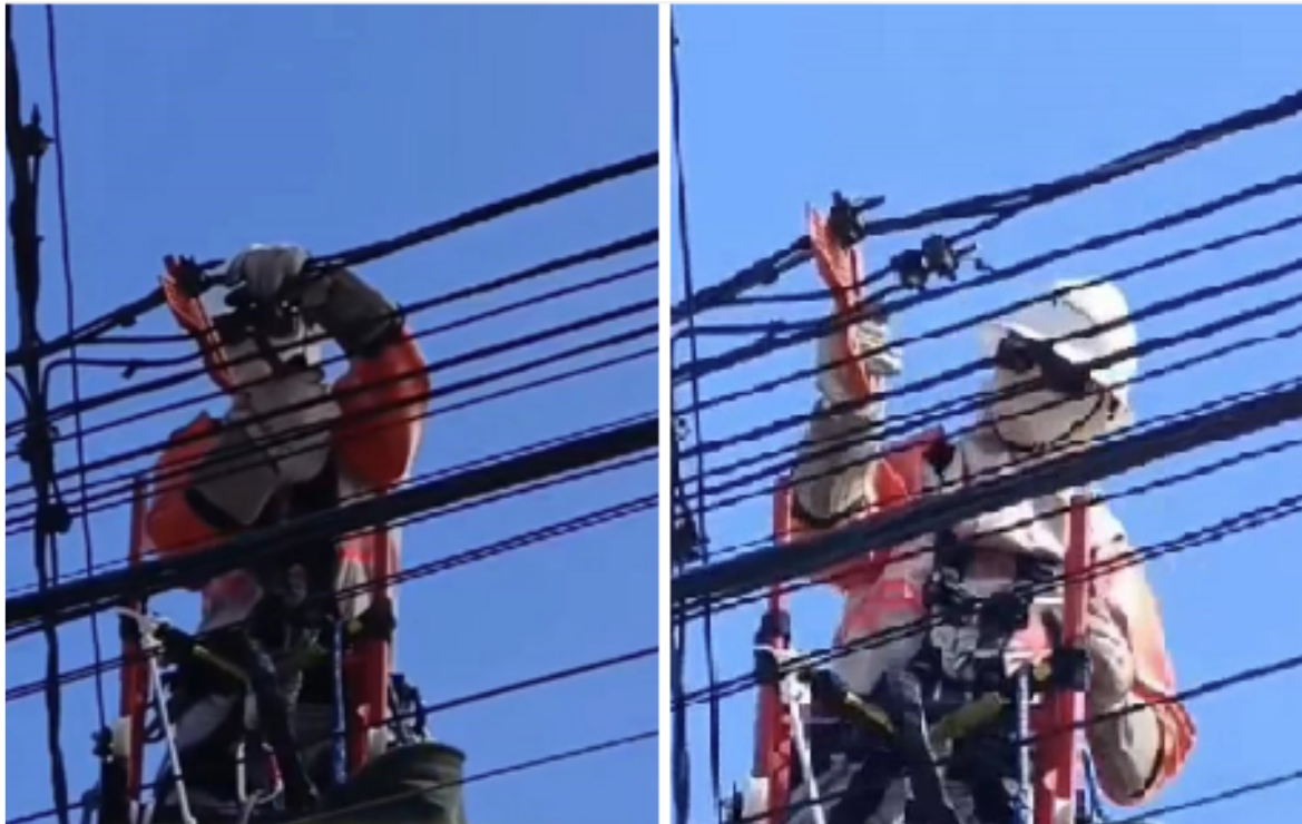
Figura 8 - Testes em campo e validação final da cunha
